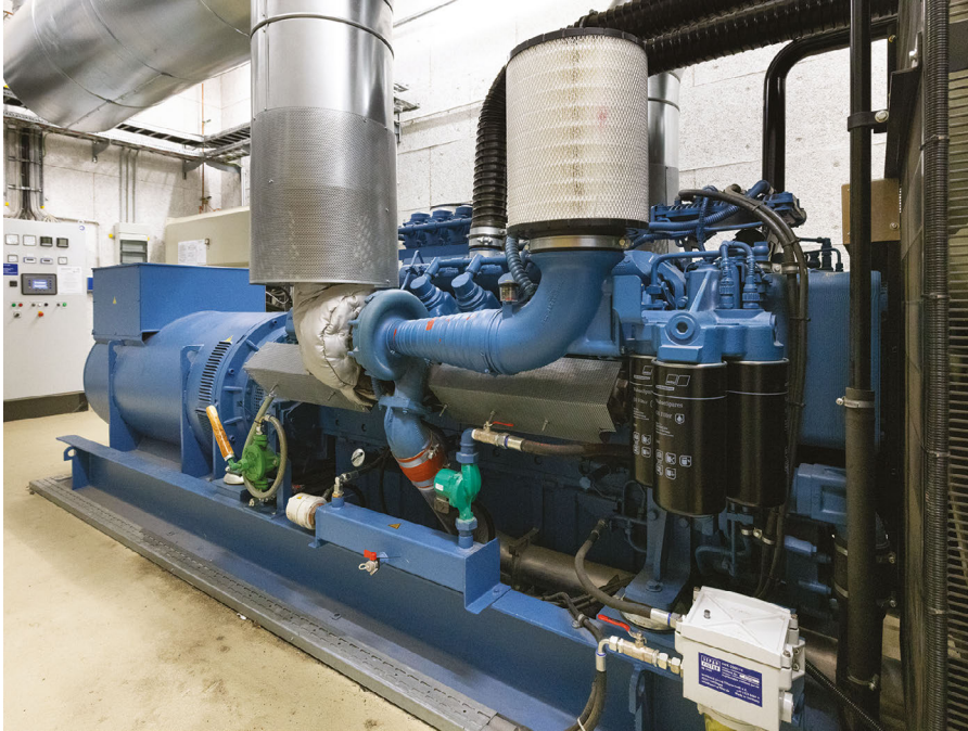
Dieselnetzersatzaggregat.
